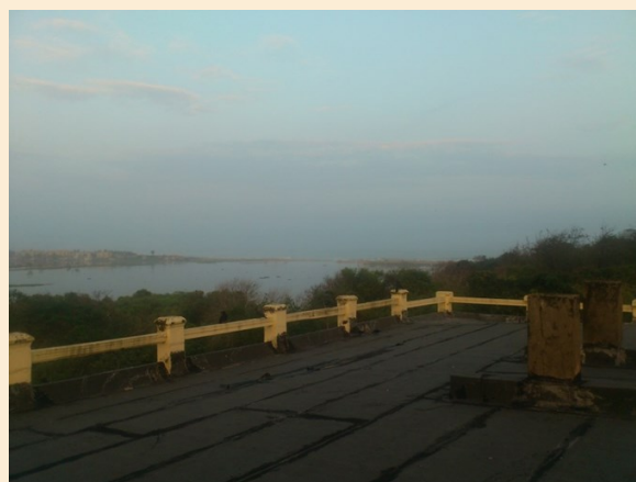
Zicht op de Adyardelta vanop het dak van Leadbeater Chambers
